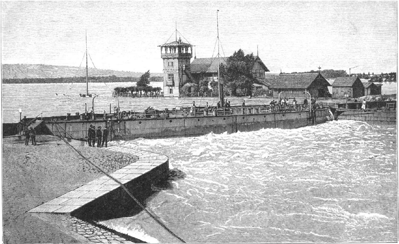
Das Schwimmthor („Spererschiff“) am Eingange des Wiener Donauranals bei Hochwasser. (Nach einer Photographie.)
