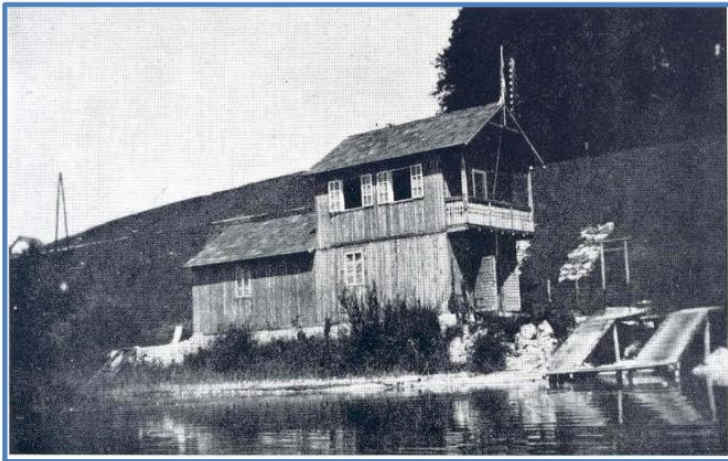
Das erste Bootshaus am Wallersee (1. Bauetappe)
