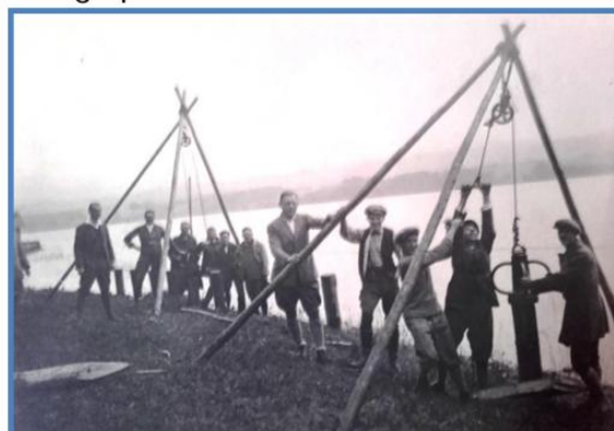
Erste Arbeiten am Ufer
