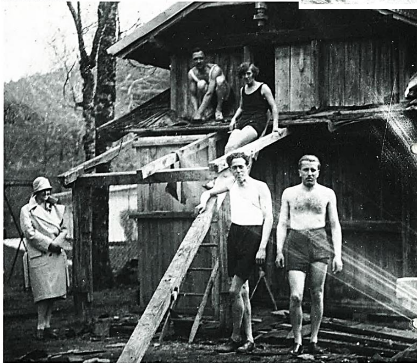
Bau des neuen Bootshauses
