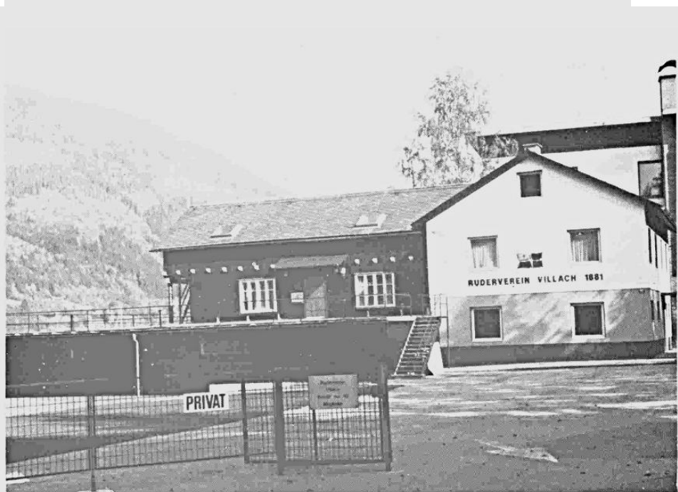
Abbildung 2.169: Das Vereinshaus mit allen neuen Zubauten 1981
